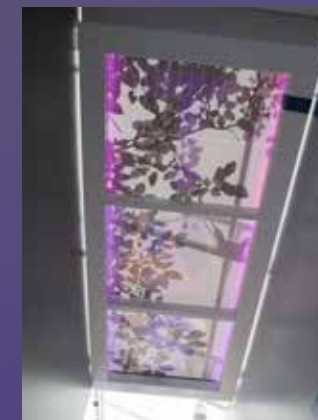
シースルーソーラー 天窓照明
