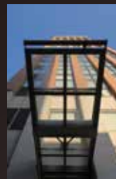
中電工平和大通ビル
